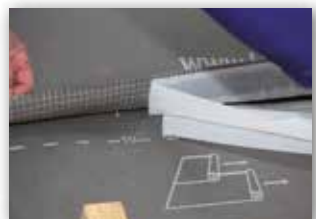
Nahtsicherung mit Doppel- klebestreifen z.B. bei Permo ® SK 2
