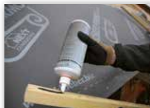
Perforationssicherung mit Konterlattendichtmasse, z.B. Permo ® seal
